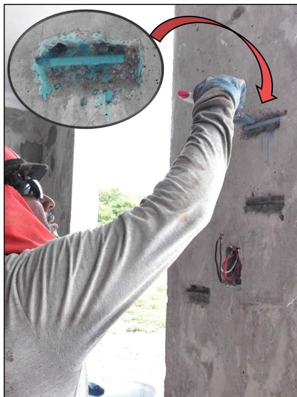
Fig.5: Aplicación de la primera capa del mortero cementoso anticorrosivo.
