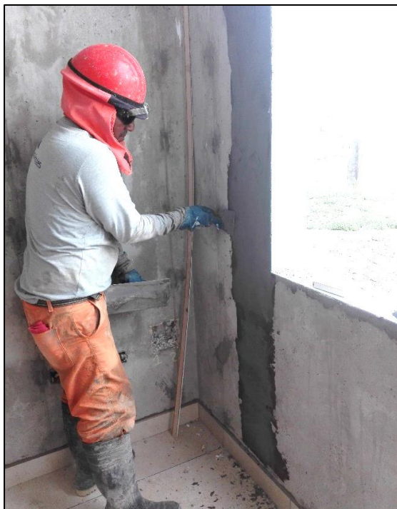
Fig.6: Aplicación de la primera capa del mortero impermeabilizante para otorgar una mayor protección.
