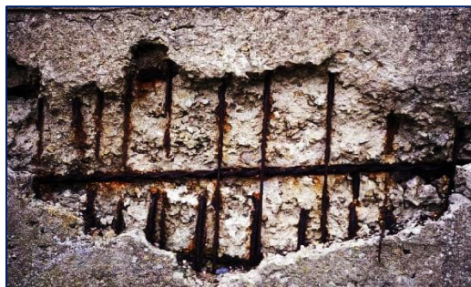
Fig.2: Armadura en proceso de corrosión. Fuente: Universidad de Cantabria.
